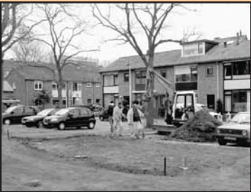
3-Hier is de grond geëgaliseerd voor het veilig maken van de vloer die hoort bij het vogelnestje.
