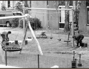
10-De afrondende werkzaamheden bij de overige speeltoestellen.
