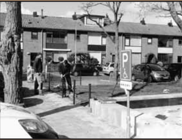
7-Hier is men hard bezig met het plaatsen van het hekwerk over ¾ van het terrein.
