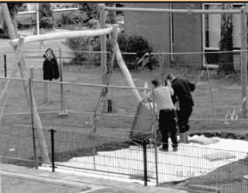
9-Onder het vogelnestje wordt een laag aangebracht die de kinderen moet beschermen bij het vallen.
